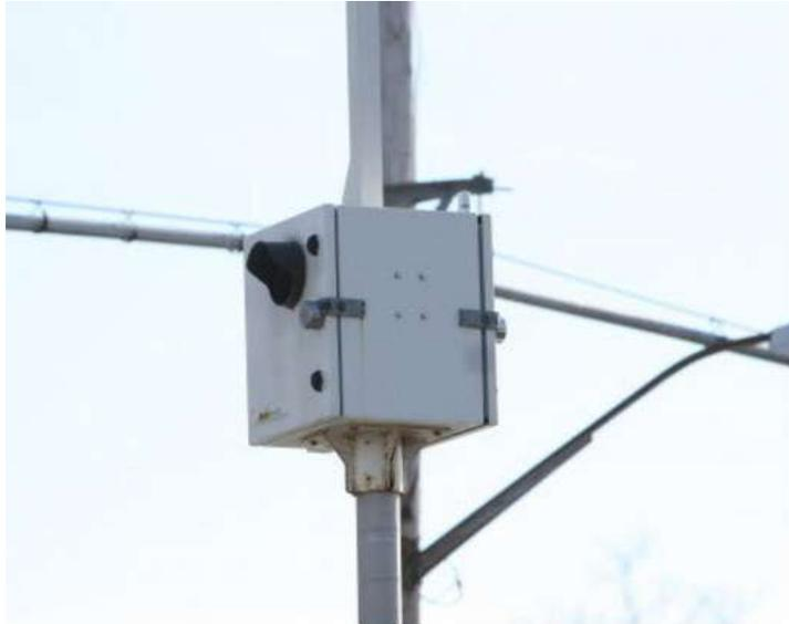
**FIGURE 9: TRAFFIC CONTROL CAMERAS**
